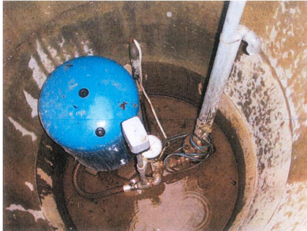
Utæthed ved ledningsgennemføring
