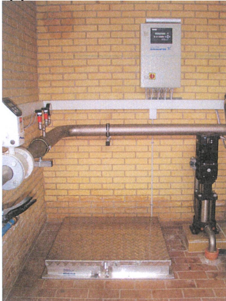
Nedgang til rentvandsbeholder
