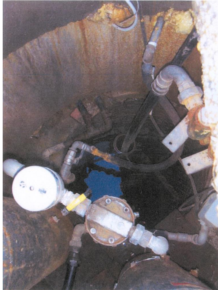
Boring i brønd med vand og uden forerørsforsegling
